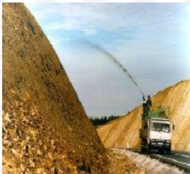
Hidrosiembra de Taludes
